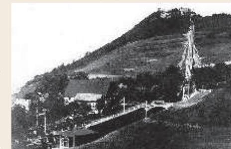
Es handelte sich um eine Standseilbahn, die das „System Abt“ verwendete: Die beiden eingehängten Wagen bewegten sich gegenläufig berg- und talwärts und begegneten sich an der sog. Abt'schen Zwangswende in der Mitte der Bergbahnstrecke, die als Brücke erhalten geblieben ist. (Nr. 5c, Bild unten)
